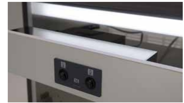
Technikfach mit Mehrfach-Steckdose
